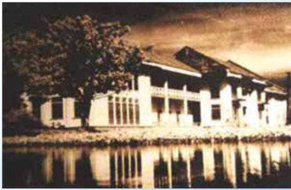
▲ อาคารเกตราทิพย์
